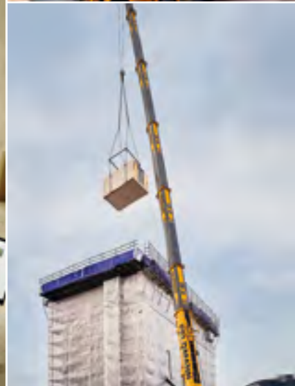
Mit solch vorgefertigten Zimmermodulbauten aus Holz wurde der neue Wohnturm Silhouette (aus einer Betonhülle bestehend) gefüllt.
