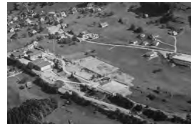
Baustelle SZK, Filzbach, 28.7.1970.
