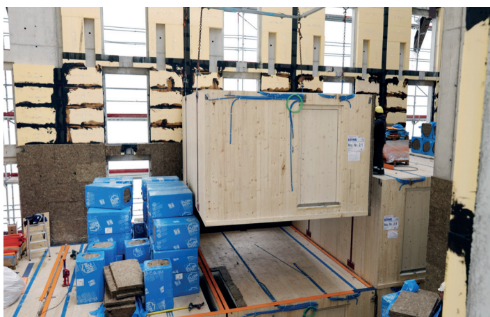
Abbildung 1: Perfekte Massarbeit beim Einsetzen der vorfabrizierten Holzmodule, welche die Zimmer des Sportzentrums bilden (Quelle Bild: Keyboost Marketing GmbH).
